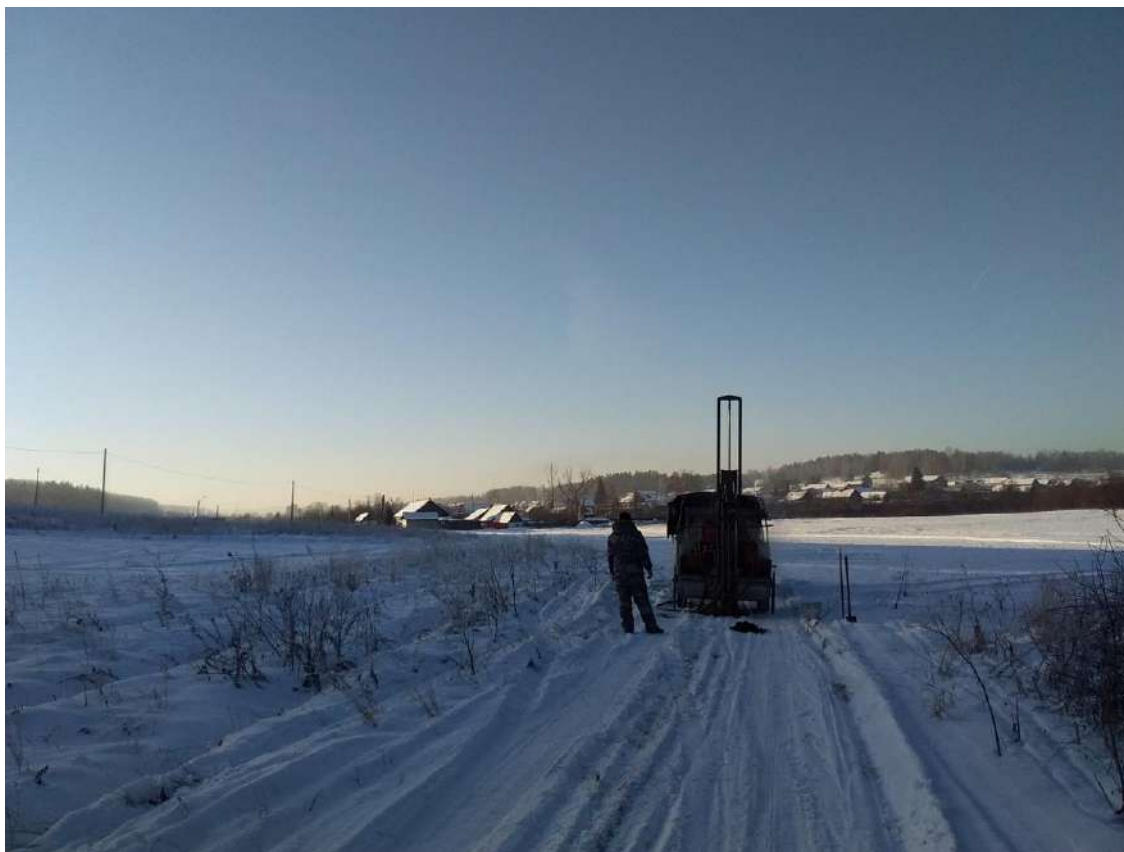
Фото 3.1.1 – Бурение скважины № 1, вид на поселок Тайнак
