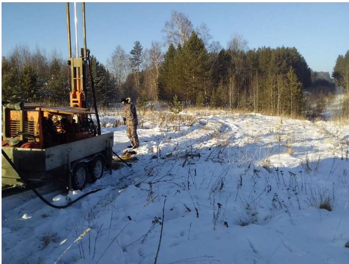
Фото 3.1.4 – Бурение скважины № 5, вид на просеку
